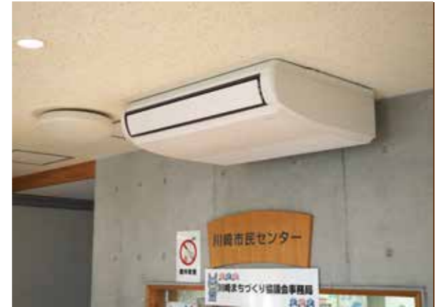
吊り下げ型の新しいエアコンが各部屋につきました
